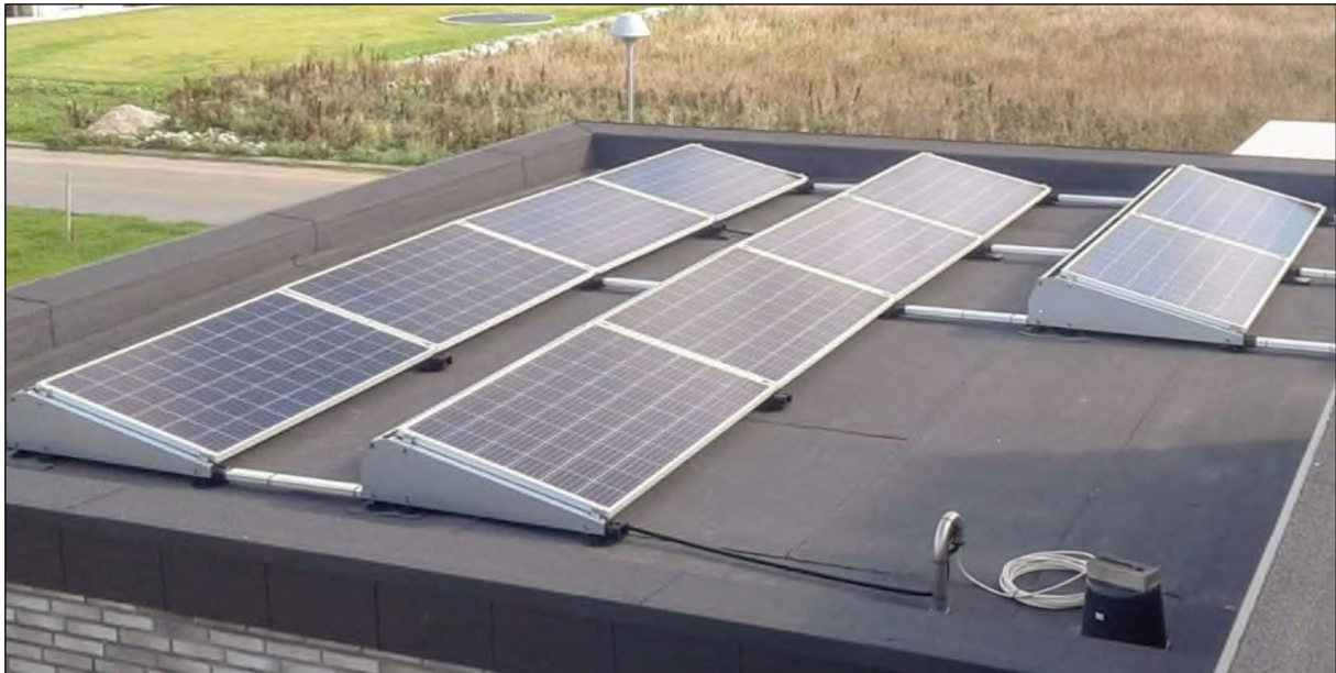
Princip for placering af solcellepaneler på taget. Kopi fra supplerende materiale modtaget af kommunen den 10. juli 2022.
